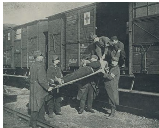
Figure 4. Évacuation des blessés par voie ferroviaire vers les hôpitaux de l'arrière. BIU Santé, Paris. D'après la réf. 22.
